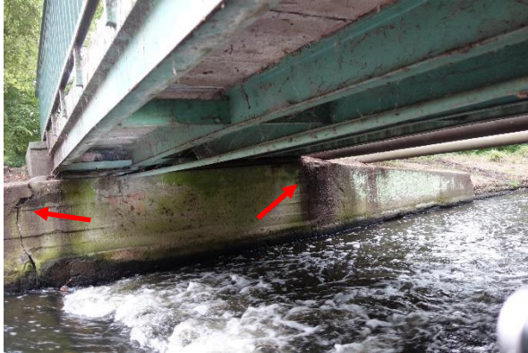
Abbildung 23: Risse an der Wand mit Potential für Fledermausquartiere
