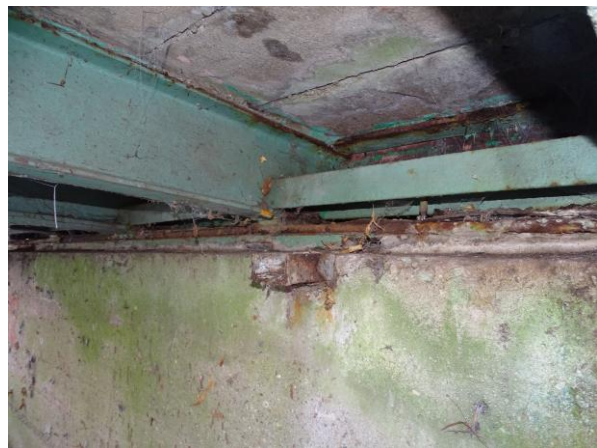
Abbildung 26: Widerlager der Brücke (Südseite)
