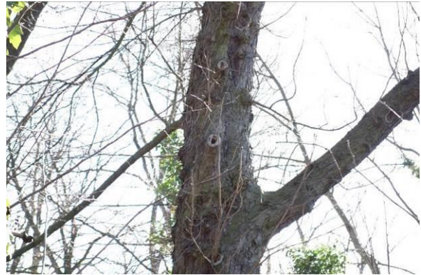
Abbildung 10: Baum Nr. 1, Astloch
